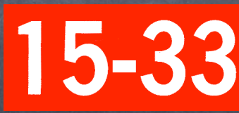
Point d'arrêt (avant intersection des pistes 15-33)
